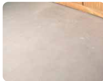
Betonilha de cimento em bom estado
